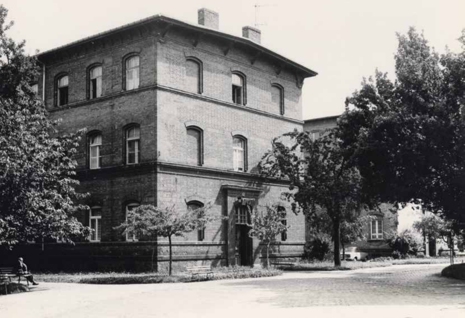
Haus 1 Riebeckstraße 63 in Leipzig, vermutlich 1970er Jahre. In den beiden oberen Etagen befand sich die Geschlossene Venerologische Station Leipzig-Thonberg. Nur die Gitter an einigen Fenstern lassen diese von außen erkennen. Foto-Zentrum Leipzig
